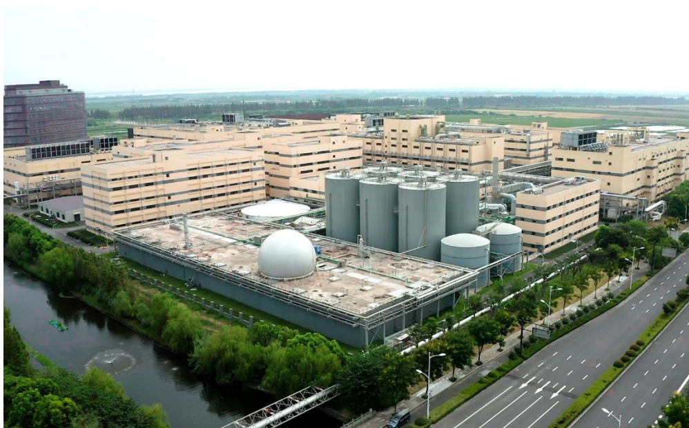
华东医药废水 EPC 总包项目
